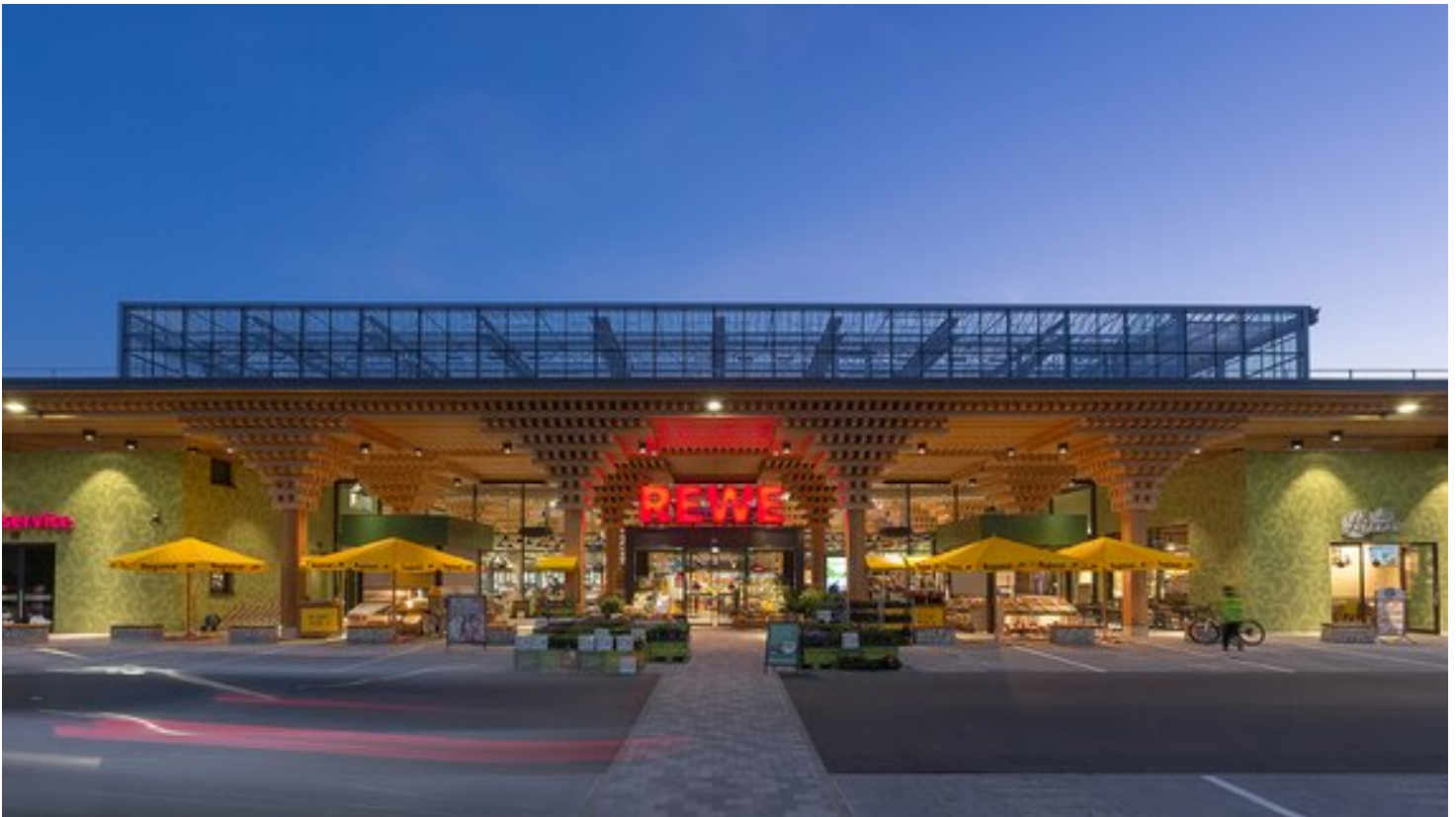
Grüner Markt: Das REWE Green Farming in Wiesbaden-Erbenheim überzeugt durch viel Holz und eine eigene Dachfarm.
