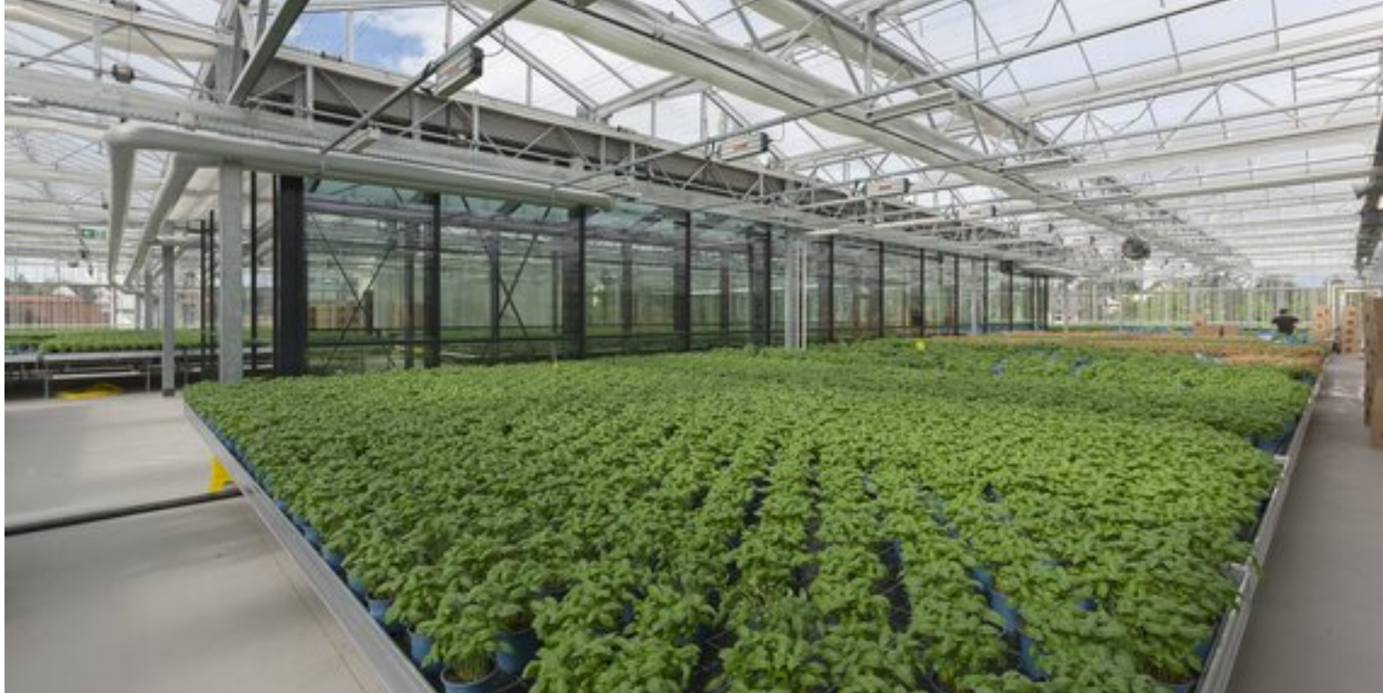
Die Dachfarm, die von Partner ECF Farmsystems betrieben wird
