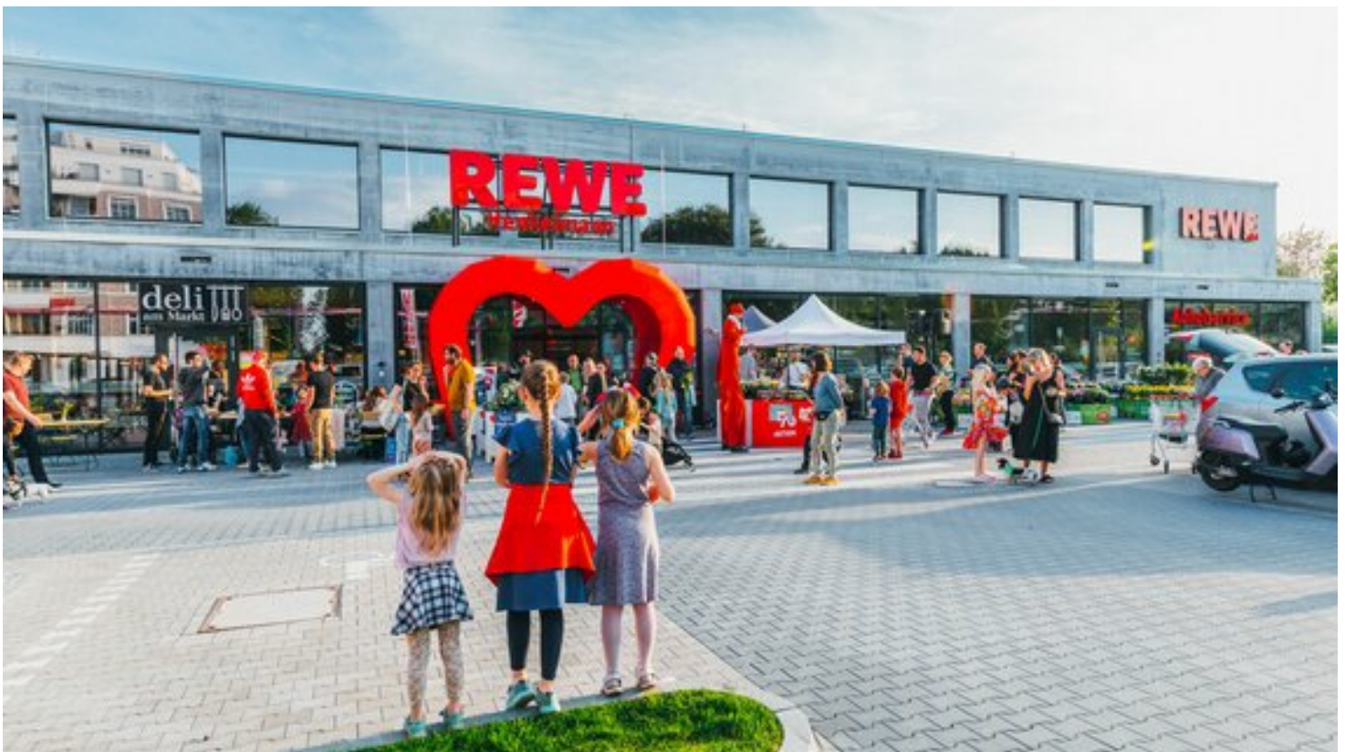
In Berlin-Friedrichshain steht der erste Supermarkt aus dem Hochleistungsbaustoff Infraleichtbeton. Fotos: Christoph Große
