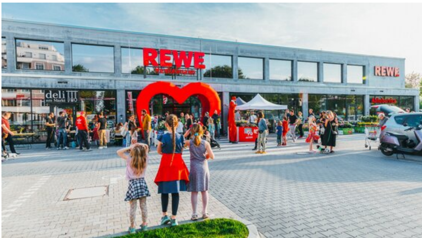
In Berlin-Friedrichshain steht der erste Supermarkt aus dem Hochleistungsbaustoff Infraleichtbeton. Fotos: Christoph Große
